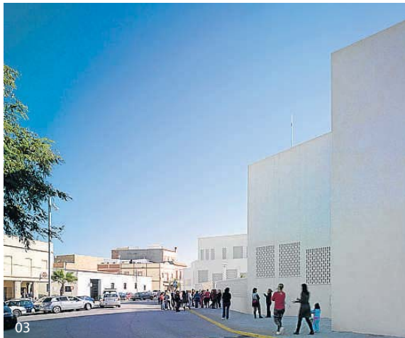
01 y 02 Diferentes soluciones de comedores resueltas con el mismo sistema constructivo (varias localizaciones, Sevilla) FOTOS: JORGE YEREGUI
